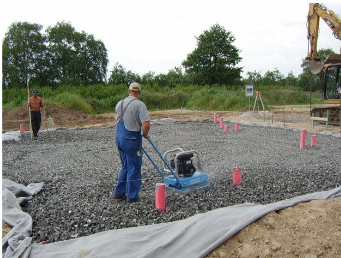
Для правильного уплотнения надо при помощи почвоуплотнителя (легкие до среднетяжелые вибрационные плиты весом <100-150 кг или самоходный каток весом до 7,5 тонн) добиться действия в глубину компрессорной мощности в соотношении к высоте установки 2:3 (рекомендации производителя).
