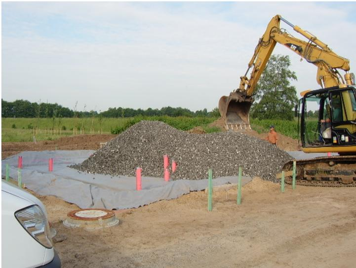
Посредством погрузчика или грабель образуется ровная поверхность по высоте насыпи для подготовки уплотнения. Из-за малого веса ( $150 \text{ кг/м}^3$ ) материал легко и быстро обрабатывается. С высоты  $> 40 \text{ см}$  необходимо уплотнять в несколько слоев.
