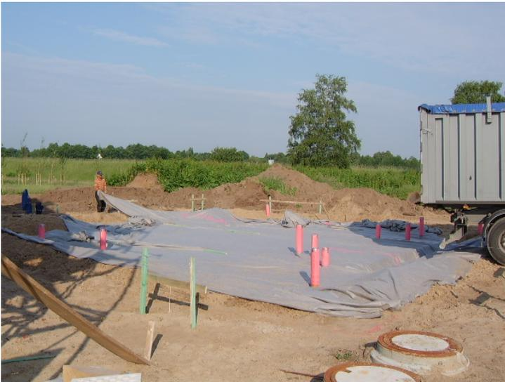
Разложить текстильный материал (150 г/м<sup>2</sup>) на грунте. В местах стыка необходим 10-ти см нахлест. По краям надо оставить достаточное количество материала для того, чтобы позднее им закрыть. Оставить столько, чтобы материал доставал до под фундаментную плиту. Текстильный материал предотвращает попадание мелких фракций в пеностекольный гравий.
