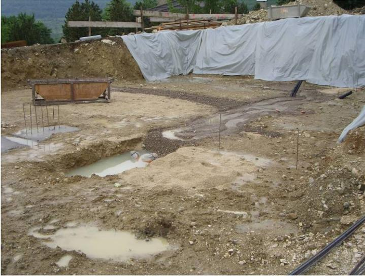
Подготовка основной площадки земляного полотна согласно расчетам. При наличии застоя воды и подпочвенной воды необходим дренаж.
